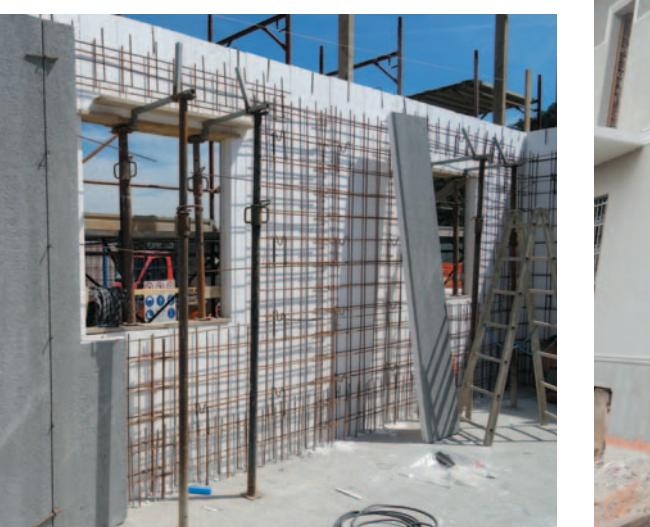
Componenti e caratteristiche del sistema Vertema3: pannello costituito da uno strato isolante in polistirene espanso di spessore variabile, armato con rete eletrosaldata sagomata e getto in C.L.S. alleggerito con palline in P.S.E., facile da tagliare, scanalare, ecc. e adattabile a qualsiasi tipologia progettuale.
